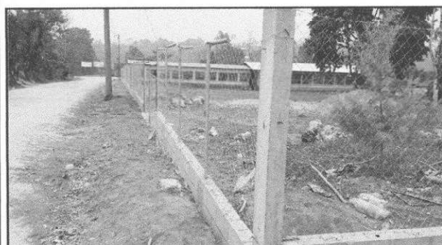
Foto 3: PARTE ORIENTE DEL PREDIO DEL ESTABLECIMIENTO, EN DONDE SE VE LA FINALIZACION COMPLETA DEL PROYECTO DE REMOZAMIENTO.
