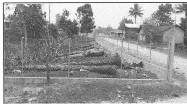
Foto 4: TRABAJO FINALIZADO AL 100%, EN DONDE SE MUESTRA LA COLOCACION DE LOS TUBOS, MALLAS Y COLUMNAS DE CONCRETO.
