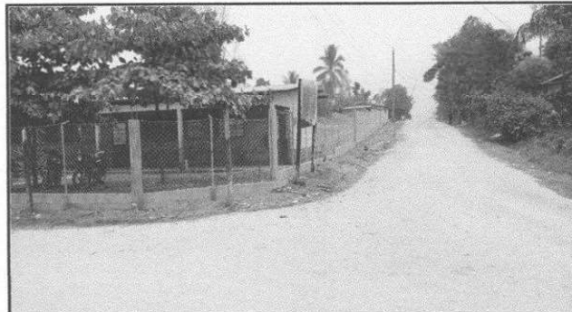
Foto 2: IMAGEN DEL CERCO PERIMETRAL 100% TERMINADO.
