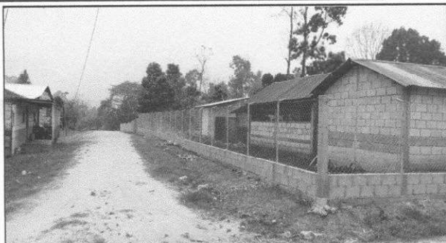
Foto1: FUNDICION DE COLUMNAS Y COLOCACION DE LOS TUBOS GALVANIZADOS.
